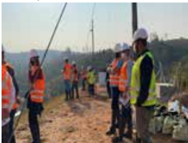
Foto 3: Comitê de Acompanhamento de Obras – Barragem Pedreira. Data: 11/08/2021.
