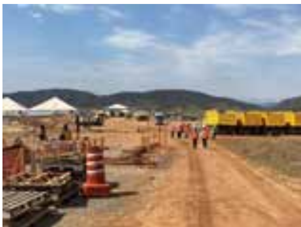
Foto 1: Comitê de Acompanhamento de Obras – Barragem Duas Pontes. Data: 12/08/2021.
